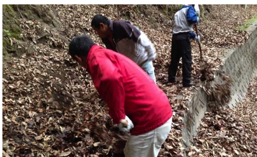
水路掃除を行う前
