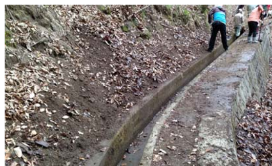
水路掃除を行った後
